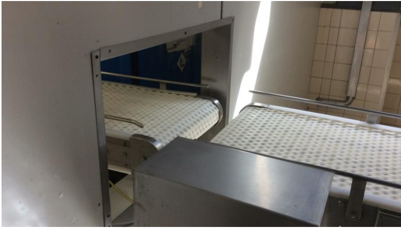
Figuur 3-4 Opening met doorvoer in brandscheiding tussen kaasmakerij en fabrieksopslag.
