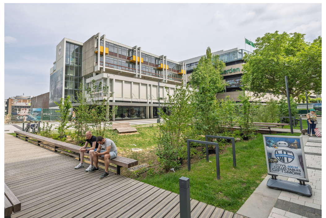
↑ Herinrichting van het Van Grunsvenplein en de Promenade in Heerlen zorgen voor verbinding met omliggende wijken en combineert vergroening, hergebruik en klimaatadaptatie., zoals de Wadi op de foto. (Beeld: gemeente Heerlen/Luc Lodder)
