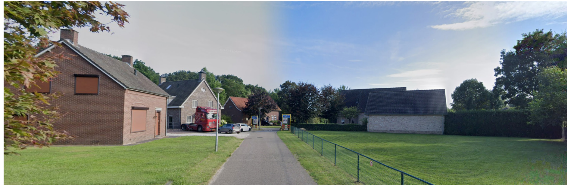
De woningen langs de Tangweg hebben een variërende rooilijn en staan variërend haaks op of parallel aan de straat
