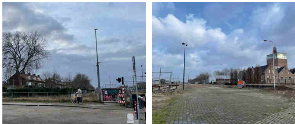
emplacement t.p.v. Regoutstraat emplacement Z-O zijde: 'niet in gebruik'
