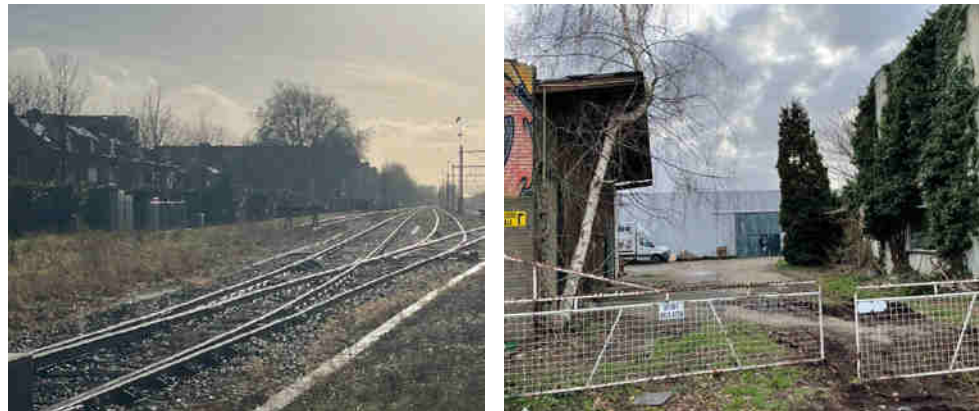
'niet in gebruik' zijnde sporen 'verwaarloosde' spoorzone noord-oost
