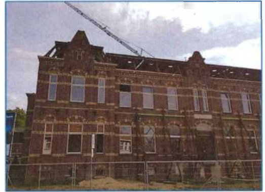
Werkzaamheden voorzijde Gasthoês
