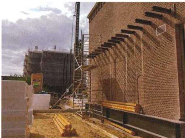
Fundering en consoles voor aanbouw achterzijde
