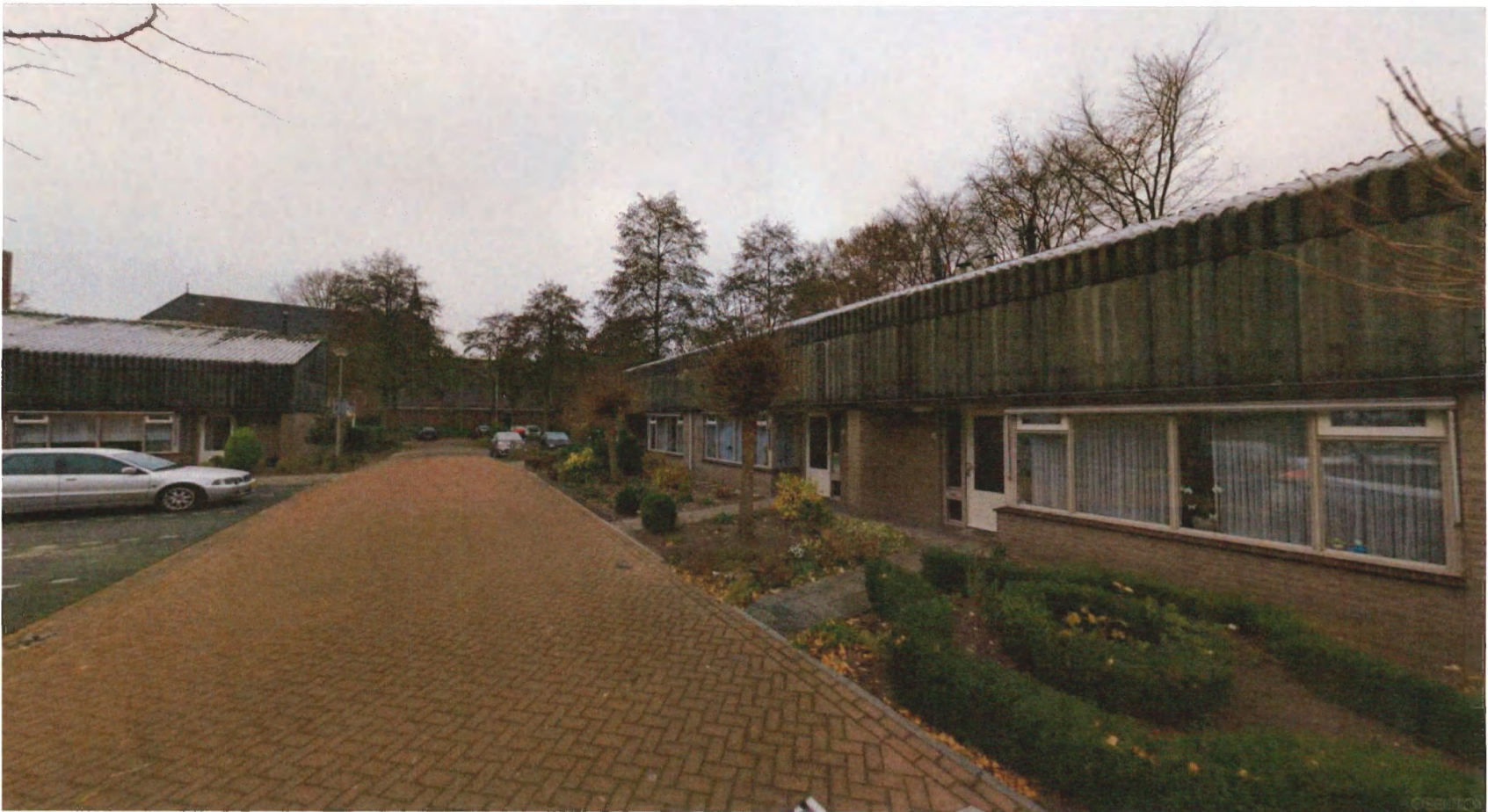
St Antoniuspark-woningen Wonen Limburg. Renovatie daken en asbestsanering. Linker rijtje sloop en nieuwbouw.
