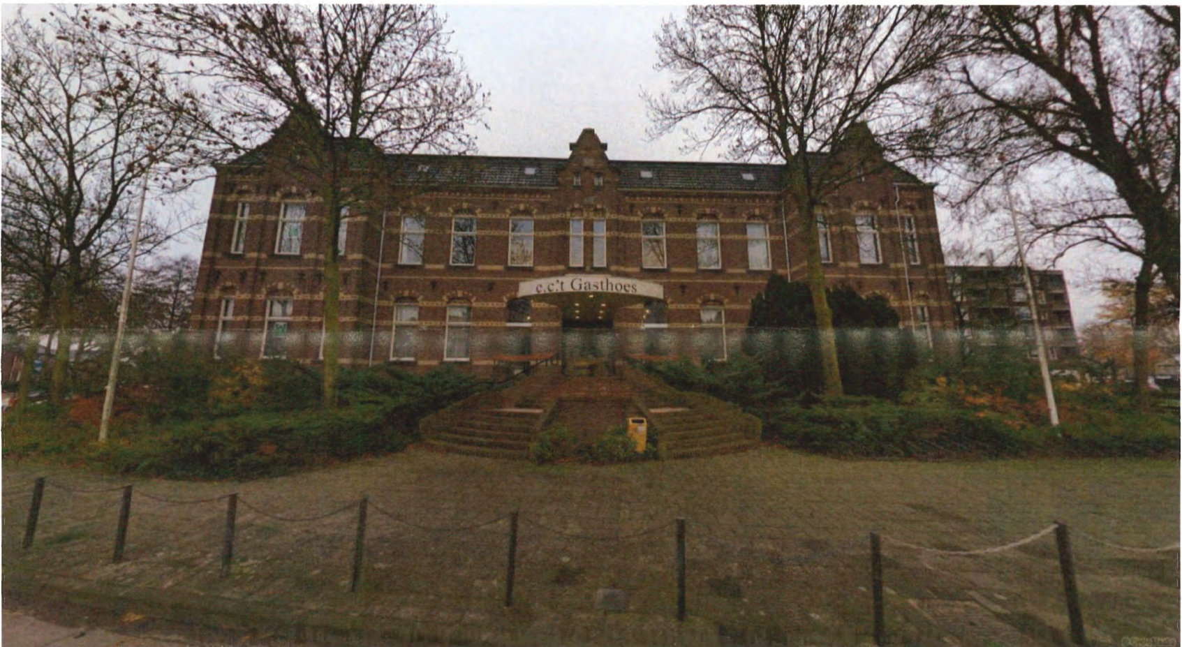
Voorgevel Gasthoës – Verwijderen trappenhuis en groen, entree naar straatniveau. Terugbrengen in historische staat. Behoud gevels.
