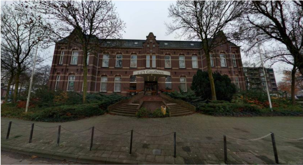
Voorgevel Gasthoëns – Verwijderen trappenhuis en groen, entree naar straatniveau. Terugbrengen in historische staat. Behoud gevels.
