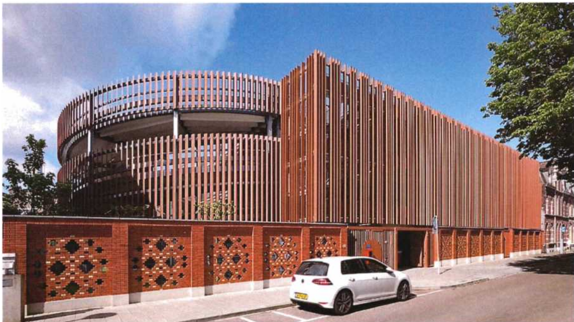
Afbeelding: nieuwe tijdelijke parkeergarage Arsenaal.
