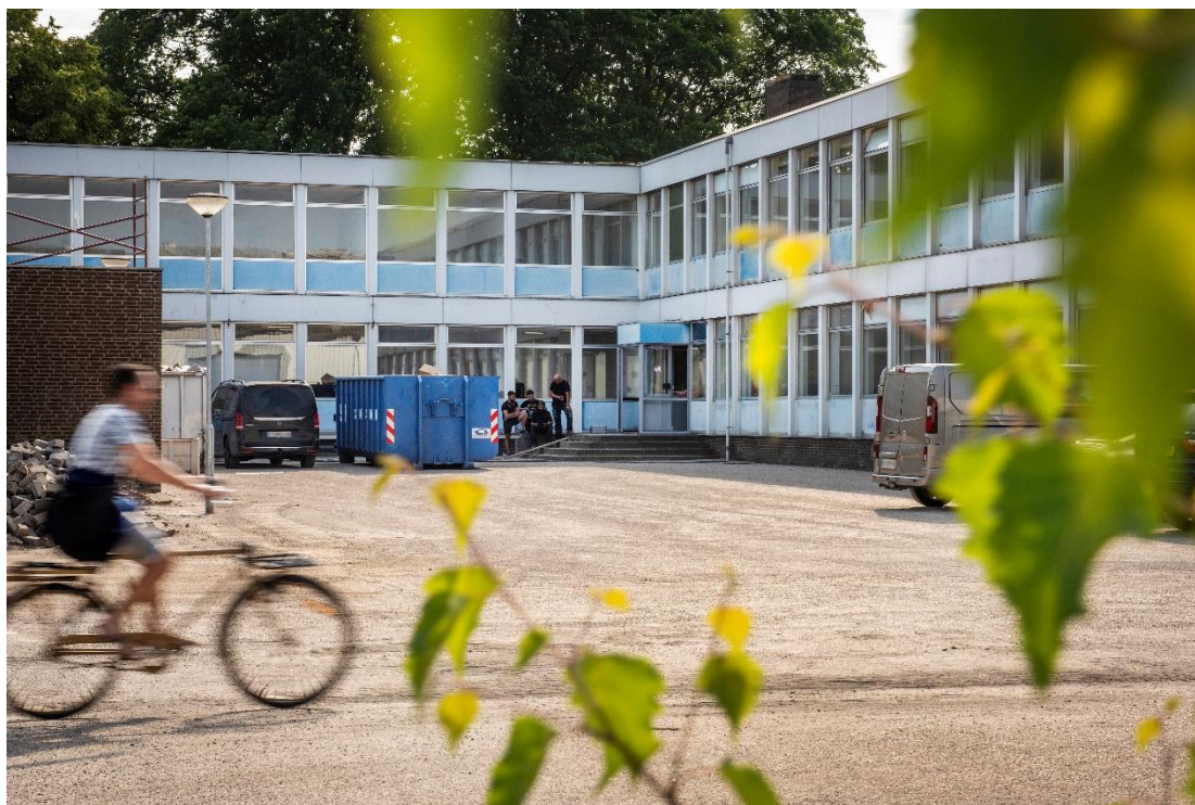
Foto: Tijdelijke huisvesting arbeidsmigranten in voormalig kantoor Stramproy
